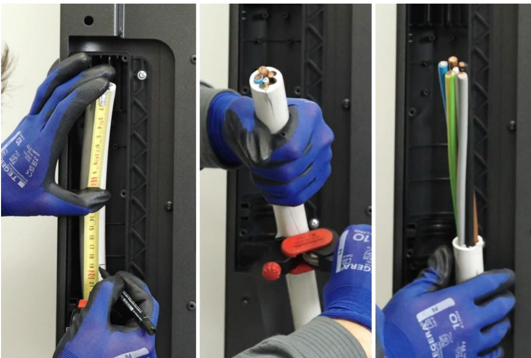
Abbildung 15: 19 cm Hauptisolierung entfernen
