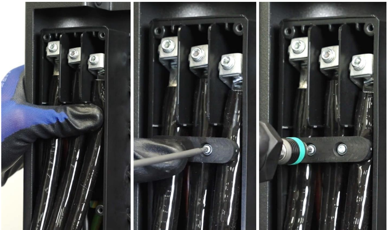
Abbildung 24: Kabelfixierung befestigen
