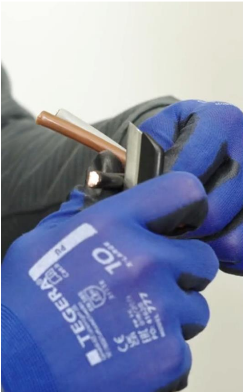
Abbildung 18: Anschlusskabel freilegen
