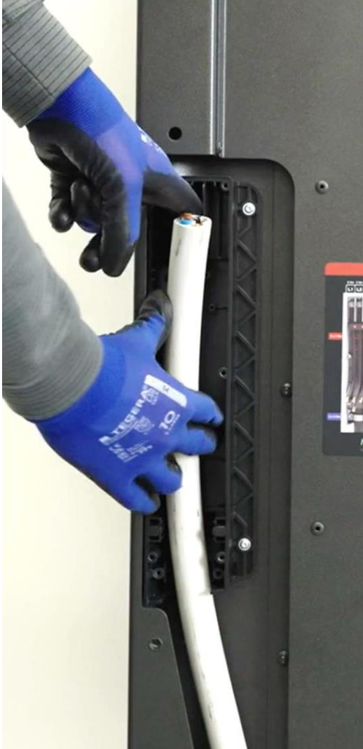
Abbildung 88: Netzkabel ausrichten
