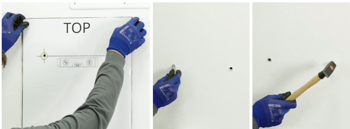
Abbildung 82: Dübel anbringen
