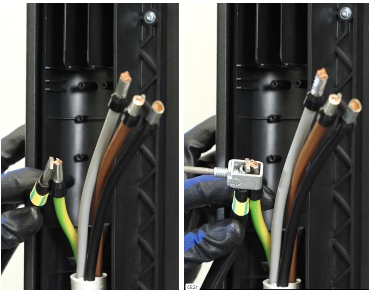
Abbildung 97: Schutzleiter und flexibles Kabel mit Kabelklemme verbinden
