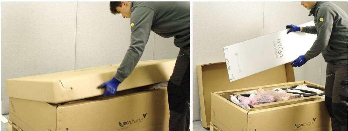
Abbildung 78: Schablone für Borlöcher entnehmen
