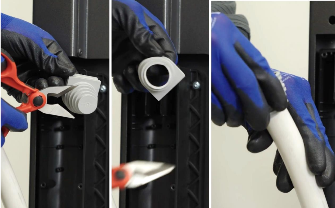
Abbildung 90: Netzkabel-Dichtung zuschneiden und anbringen
