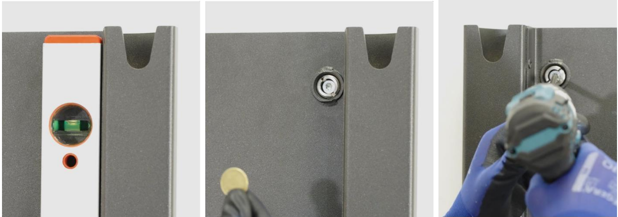
Abbildung 85: Wandmontageplatte ausrichten und fixieren
