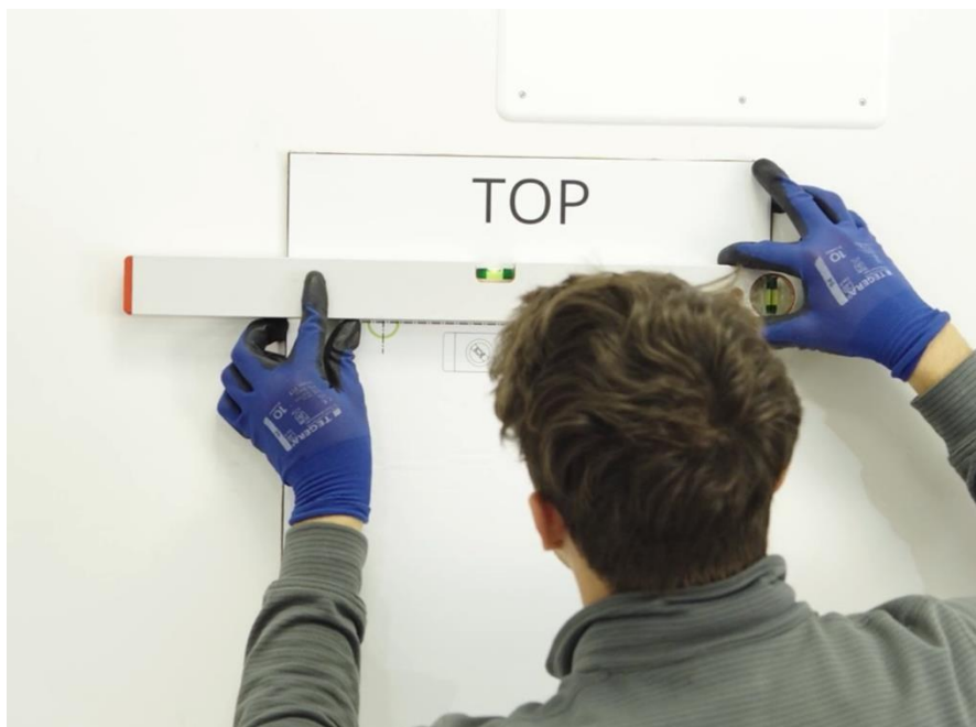
Abbildung 80: Ausrichtung der Bohrlöcher prüfen
