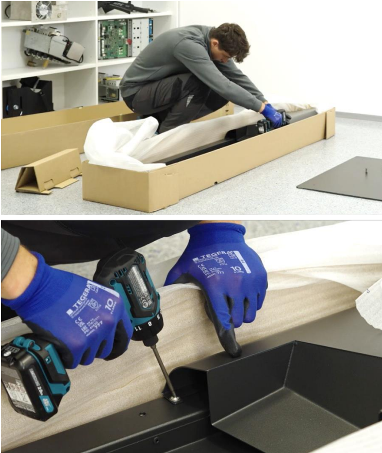
Abbildung 5: Abdeckung vom Standfuß lösen
