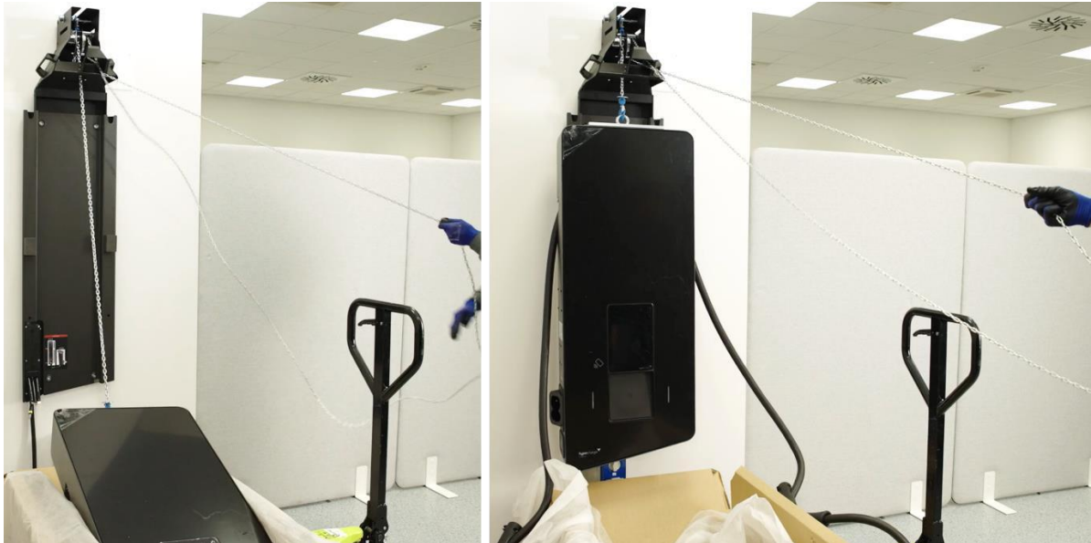
Abbildung 113: HYC50 an Kette hochziehen
