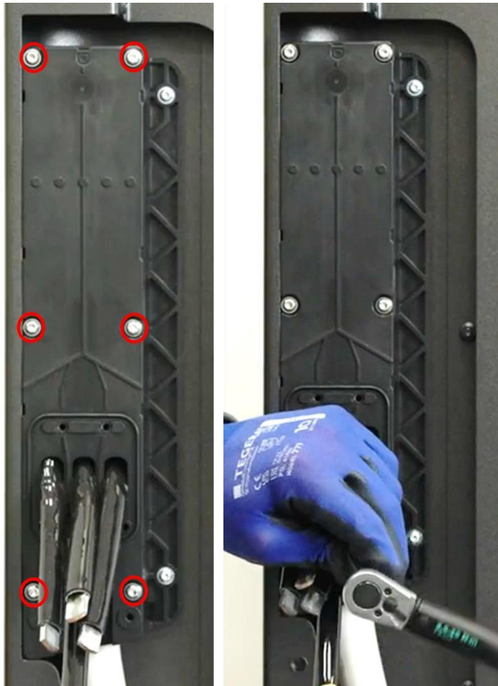
Abbildung 102: Abdeckung der AC-Netzanschlussbox anbringen
