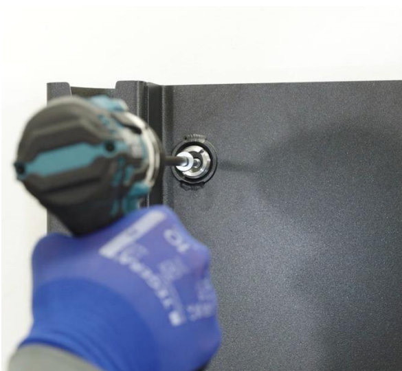
Abbildung 84: Wandmontageplatte befestigen
