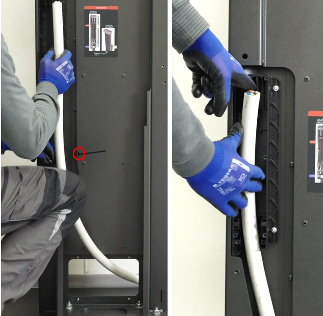
Abbildung 12: Netzkabel befestigen
