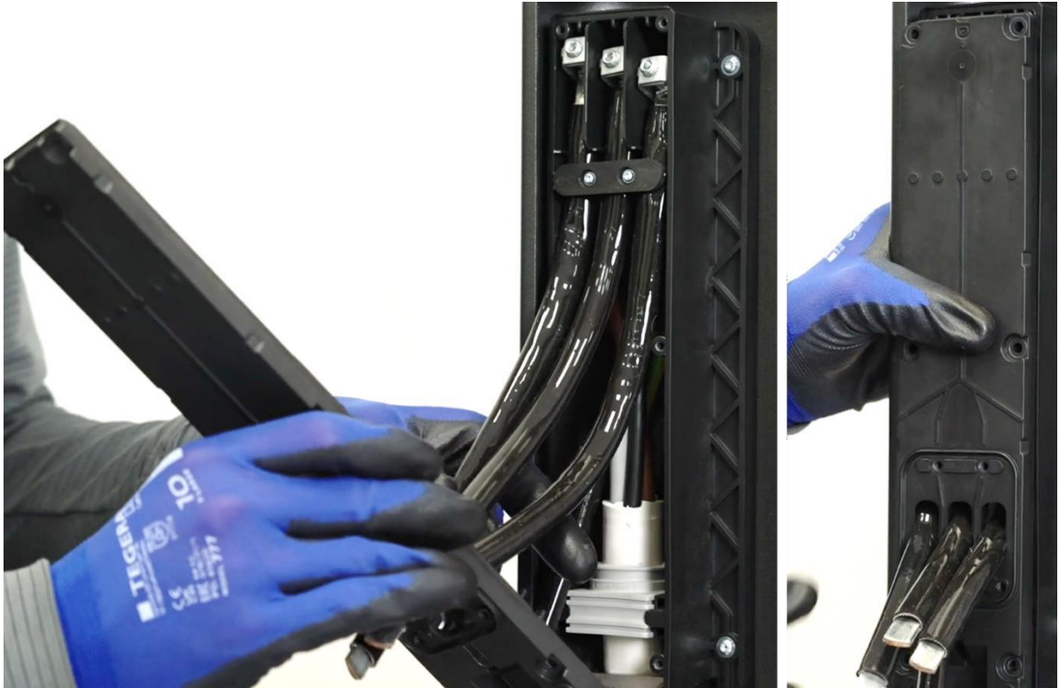
Abbildung 25: AC-Netzanschlussbox verschließen
