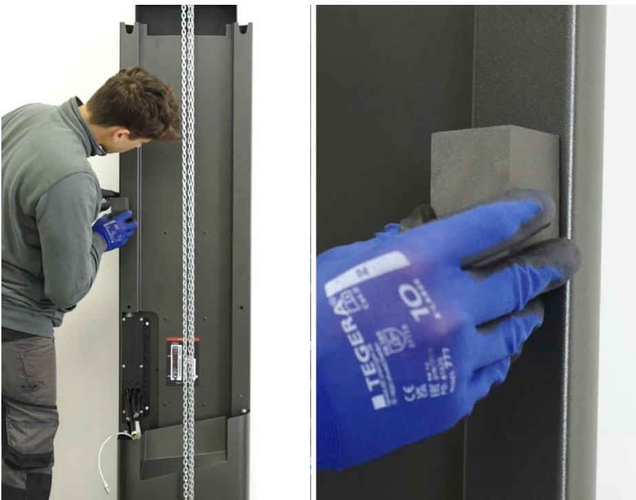
Abbildung 38: Abstandshalter befestigen
