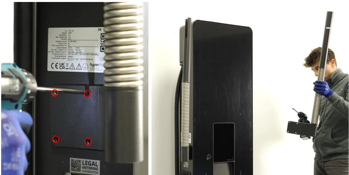
Abbildung 71: Kabelmanagement links anbringen
