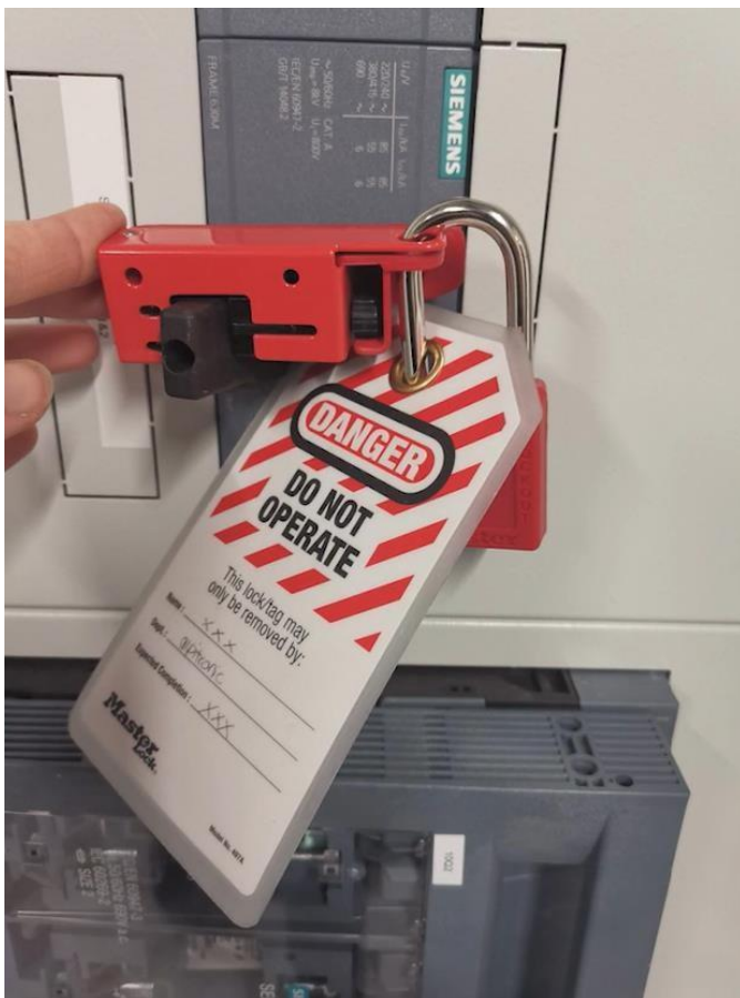
Abbildung 1: Stromversorgung netzseitig ausschalten
