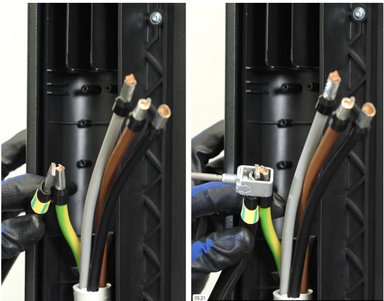
Abbildung 21: Schutzleiter und flexibles Kabel mit Kabelklemme verbinden
