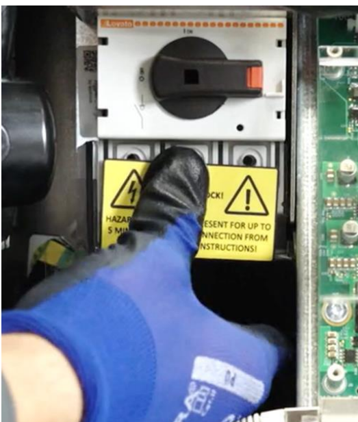
Abbildung 138: Berührungsschutz fixieren
